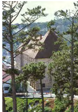
Nha Địa Dư nhìn từ phía sau
